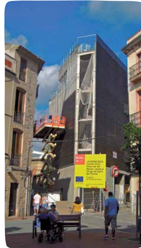
Construcción de nuevo edificio junto a los antiguos lavaderos públicos para el Centro Cívico y Centro de las mujeres. Barrio del Carme, Reus, 2010.
