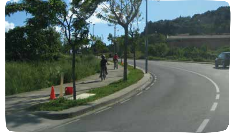
Calle de la red cotidiana (Av. Montserrat) que conecta los diferentes núcleos con espacio para los recorridos peatonales y en bicicleta, 2013.
