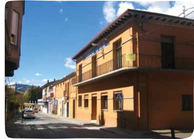
Edificio en esquina original de La Cooperativa y anexo, 2013.
